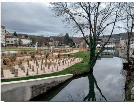
Inauguration des travaux de la Place Fontanges à Villefranche-de-Rouergue
